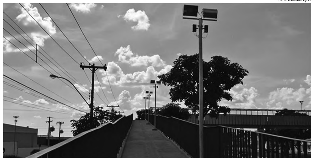
ILUMINADA - Prefeitura conclui obra e ilumina a passarela sobre a Osny Matheus
