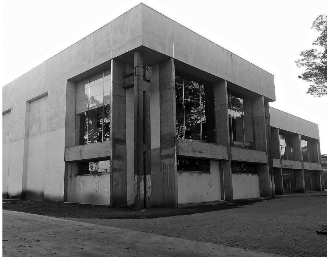
FINALIZAÇÃO - Construção do Teatro Municipal já tem 80% do seu cronograma de obras cumprido
