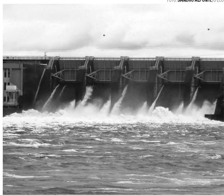
CHUÁ - AES abriu vertedouros da barragem para escoar a água
