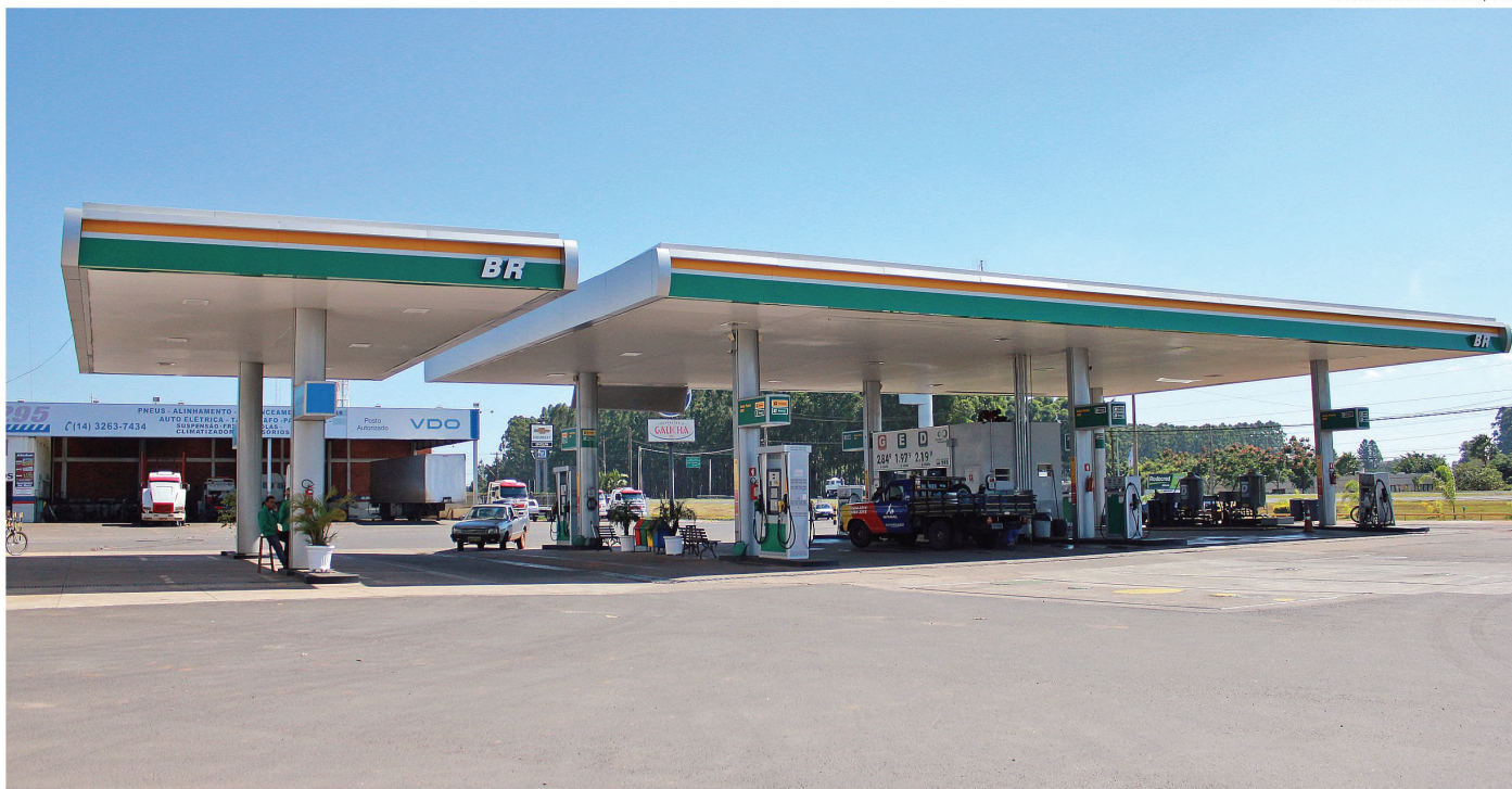
DIESEL S10 – Auto Posto 295 oferece novo diesel e os melhores combustíveis certificados pela Petrobras
