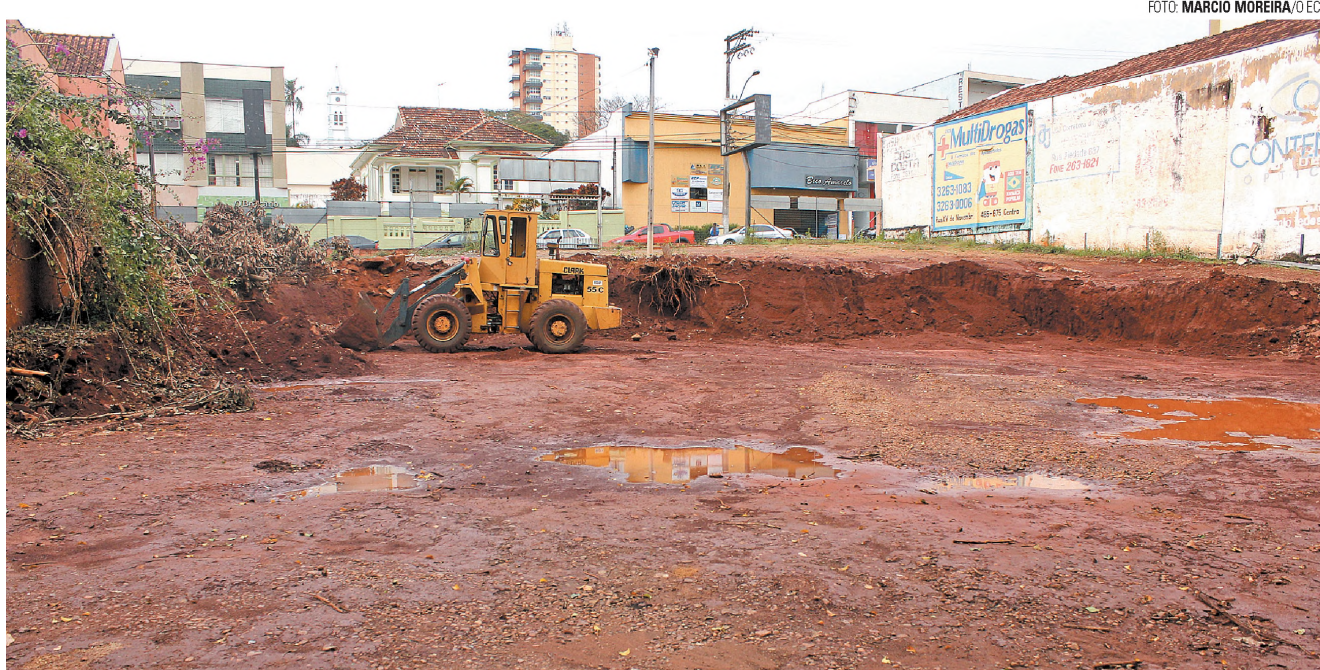
MOVIMENTAÇÃO - Terraplanagem do terreno é a primeira etapa da obra para receber Lojas Americanas em Lençóis Paulista
