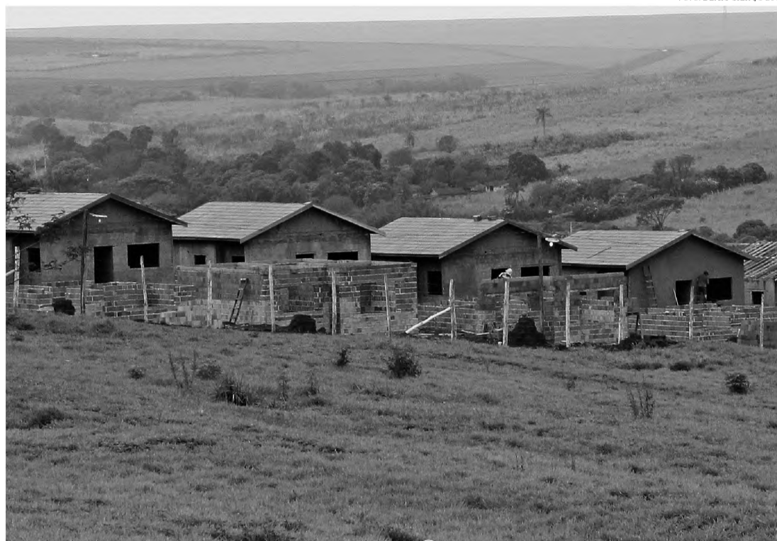
SONHO – Mais de 7 mil pessoas devem acompanhar sorteio das 452 casas do Jardim Carolina; casas seguem em obras
