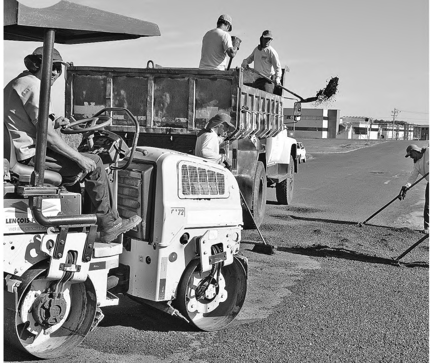
TAPA BURACO - A Diretoria de Obras e Infraestrutura retoma nesta terça-feira, a operação tapa buracos em ruas do Jardim das Nações, Nova Lençóis e no entorno do futuro terminal rodoviário de Lençóis Paulista. Serão usadas sete toneladas de massa asfáltica quente na operação.
