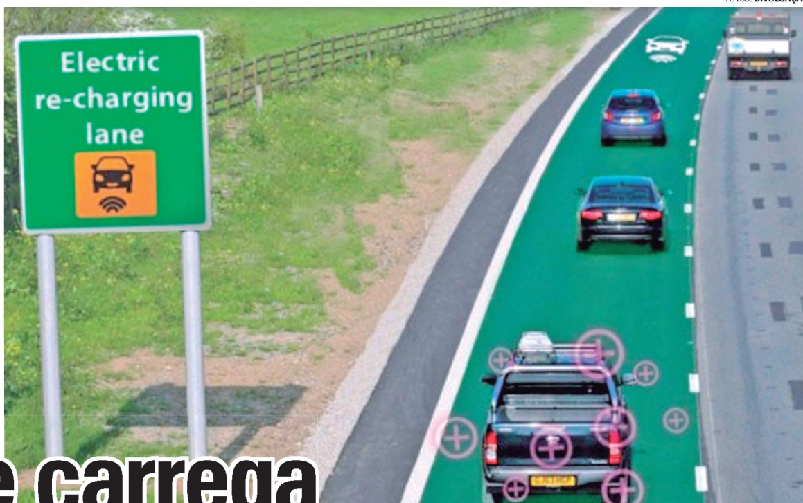
FACILIDADE – O sistema britânico tem cabos no subsolo que criam campo magnético para carga
