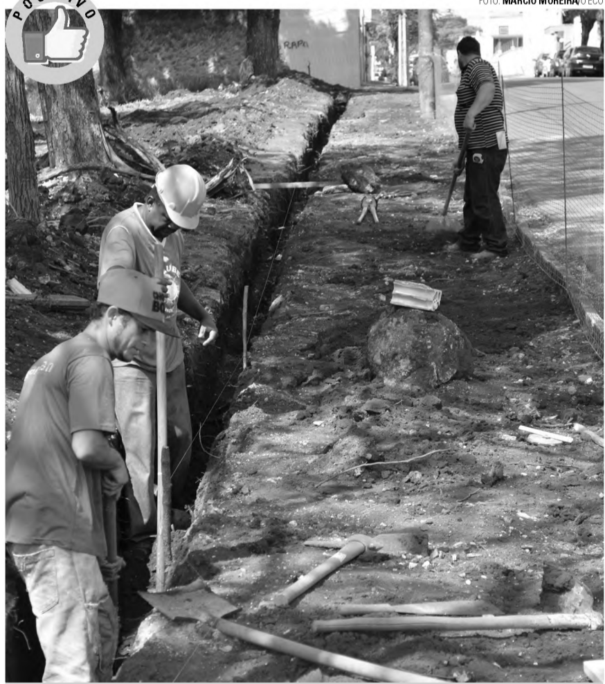
REFORMA – Nesta semana, iniciou uma reforma no muro da escola estadual Dr. Paulo Zillo, uma das mais antigas e tradicionais de Lençóis Paulista. Uma tela de proteção foi instalada para proteger os alunos das obras que seguirão no local.
