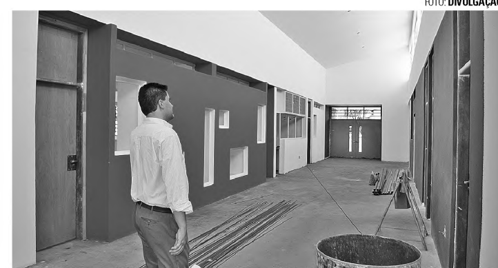
NA OBRA - O prefeito Tarcísio visita creche-escola que deve ser entregue nos próximos meses em Macatuba
