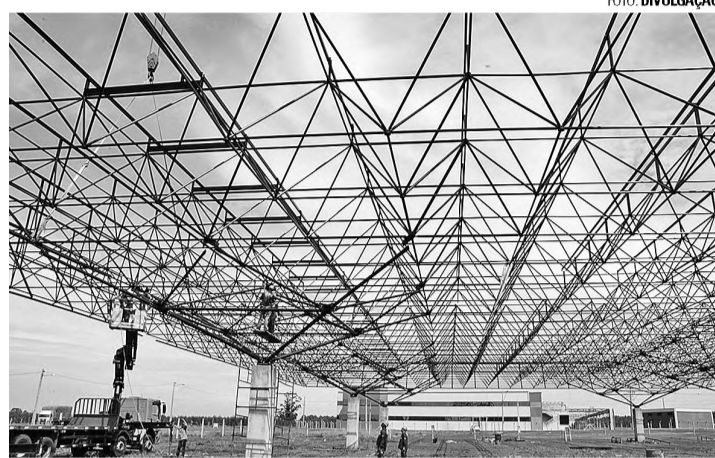
QUASE - Teto da nova rodoviária de Lençóis começa a ser instalado
