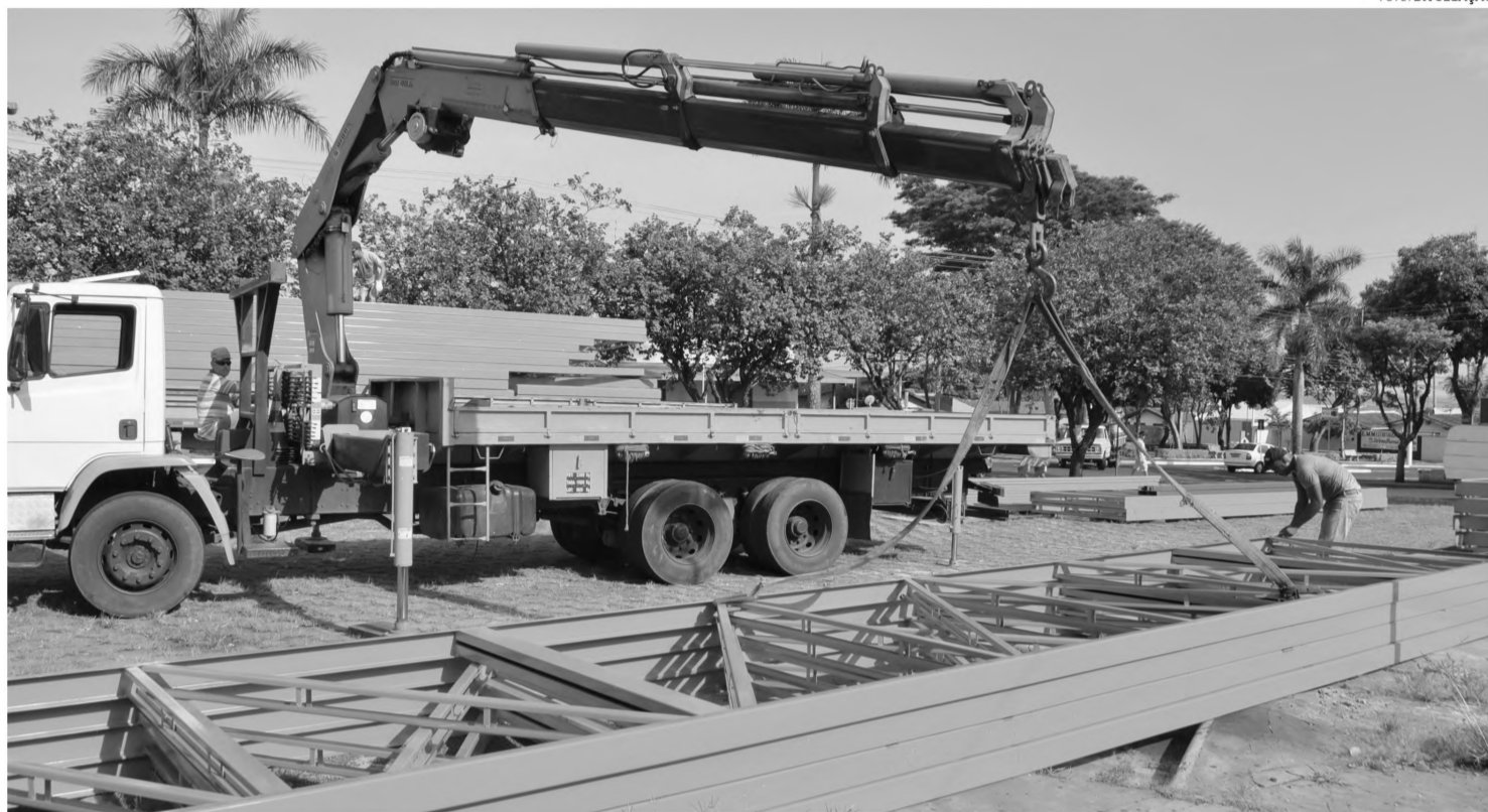
NOVO TETO - Empresa inicia montagem de cobertura de rodoviária que foi danificada por uma forte chuva no ano passado
