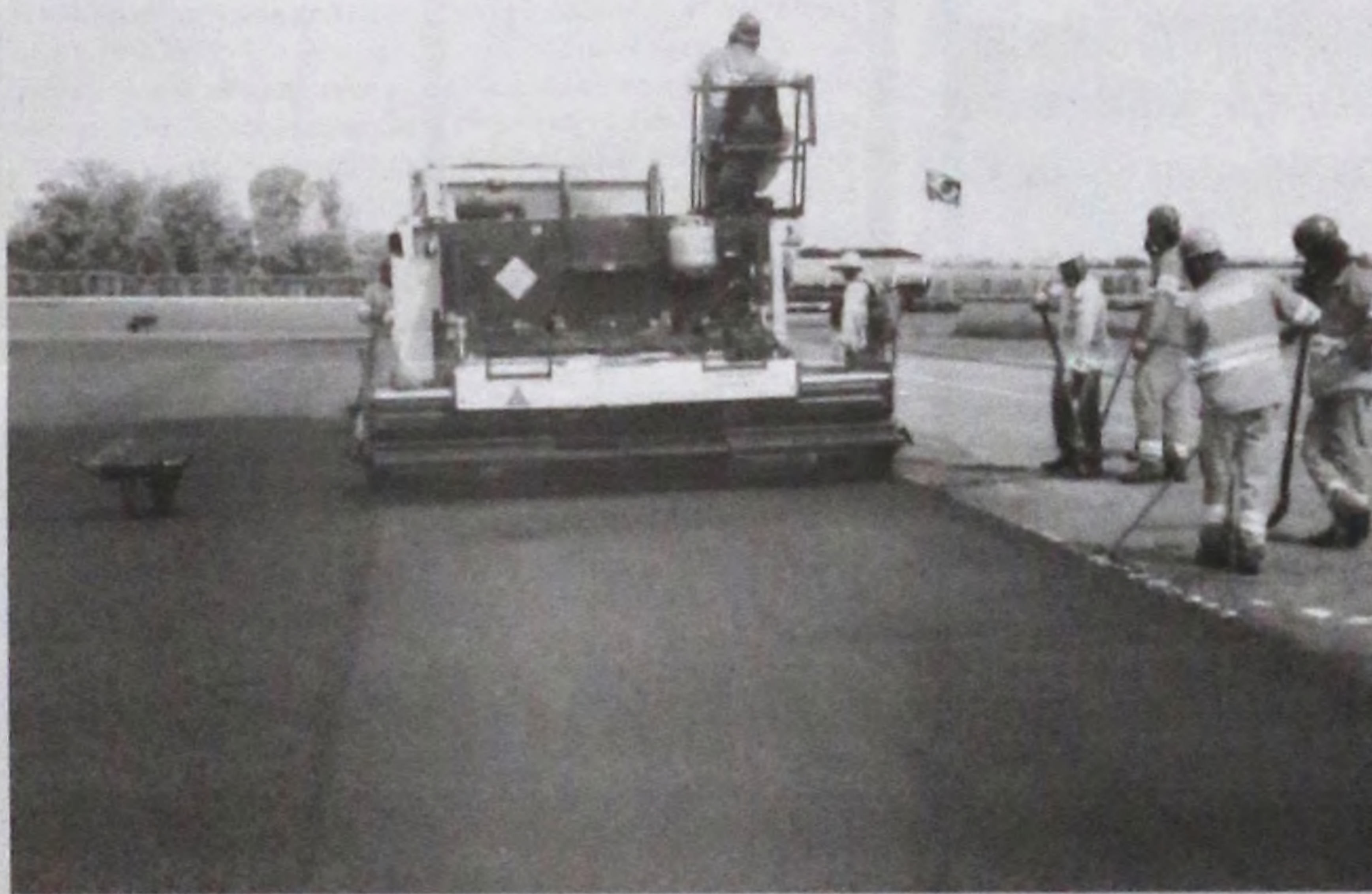
A pavimentação contempla uma área de mais de dois mil metros quadrados
