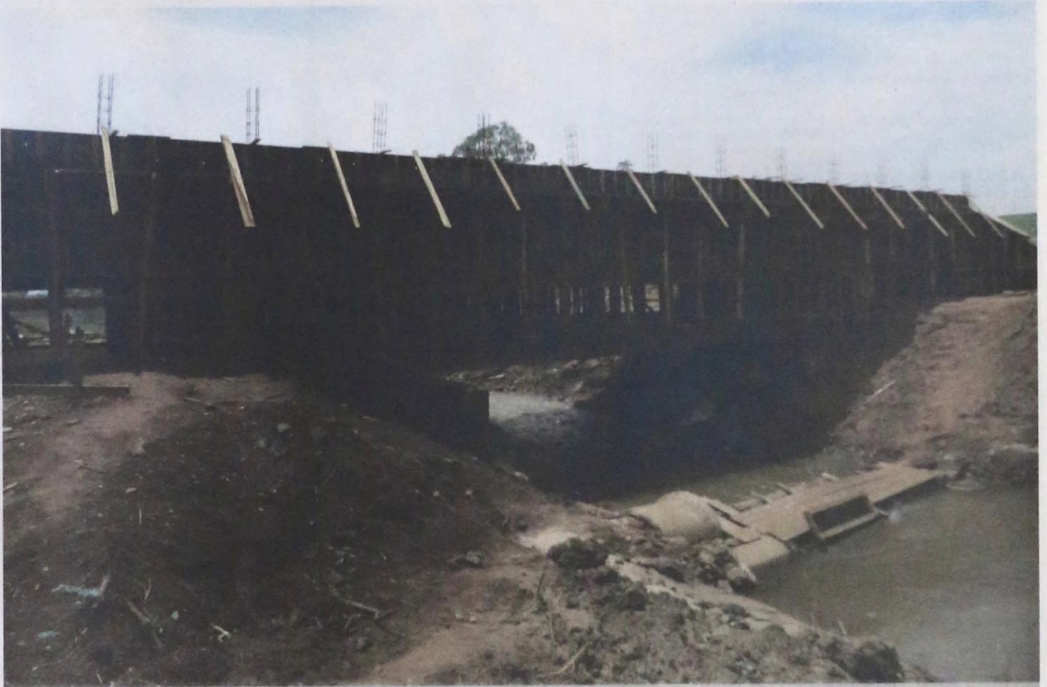
Obras da ponte de concreto sobre o Rio Faxinal: A ponte terá uma extensão de 23 metros de comprimento
