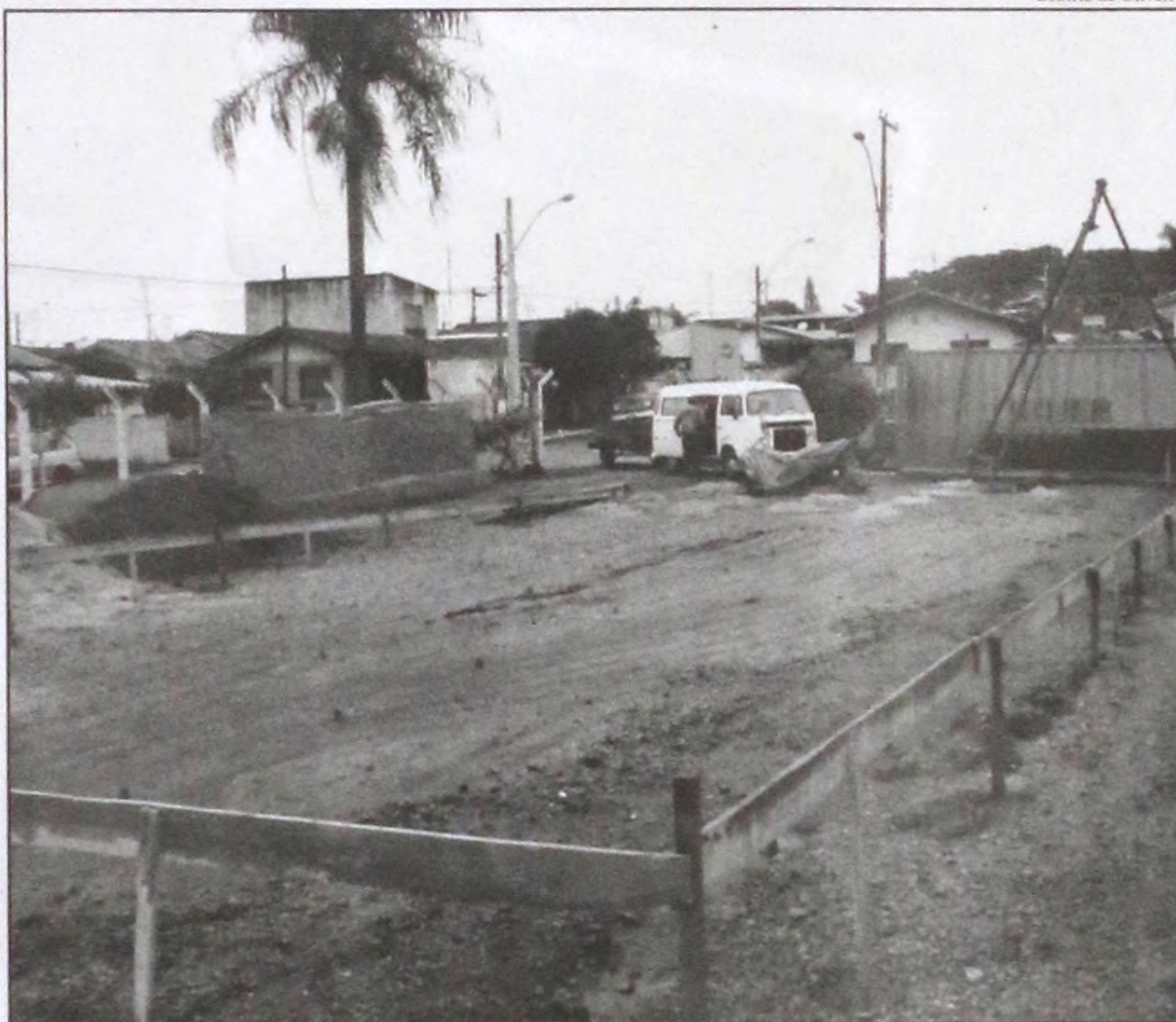
A fundação do terreno que abrigará a nova sede já foi iniciada nesta semana
