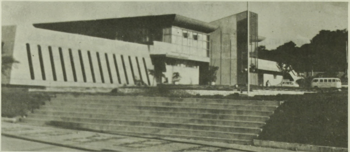
Prédio da Prefeitura, anexo as instalações da Câmara Municipal
