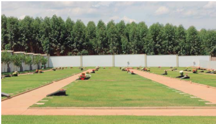
ESTRUTURA - Depois da conclusão das obras, local terá capacidade para mais de 6 mil jazigos
