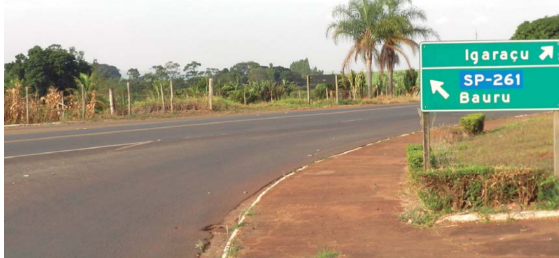
INTERDITADA - Vicinal Lauro Peraçoli deve ficar interditada por 90 dias para obras
