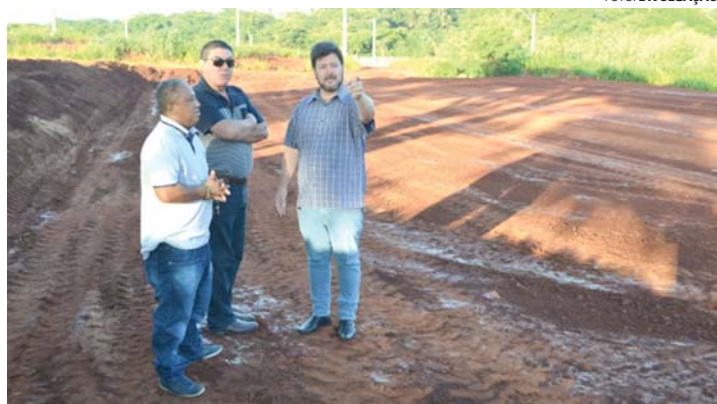
INÍCIO - Obras da futura quadra de futebol society, em construção do Parque do Povo tiveram início ontem (9)
