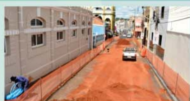
Obras de alargamento das calçadas da Rua 15 de Novembro
