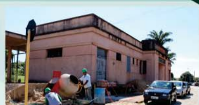
Restauração da Estação Sorocabana para receber o Terminal Rodoviário Interbairros
