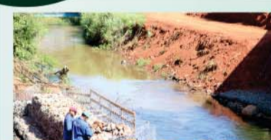
Reconstrução de passarela do Jardim Primavera
