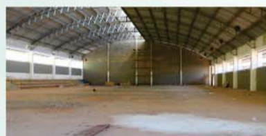
Finalização das obras do ginásio paradesportivo da Adefilp
