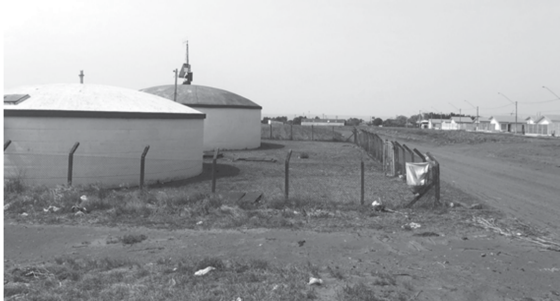
OBRAS - Poço profundo e reservatório serão construídos em área localizada no núcleo João Leme do Prado
