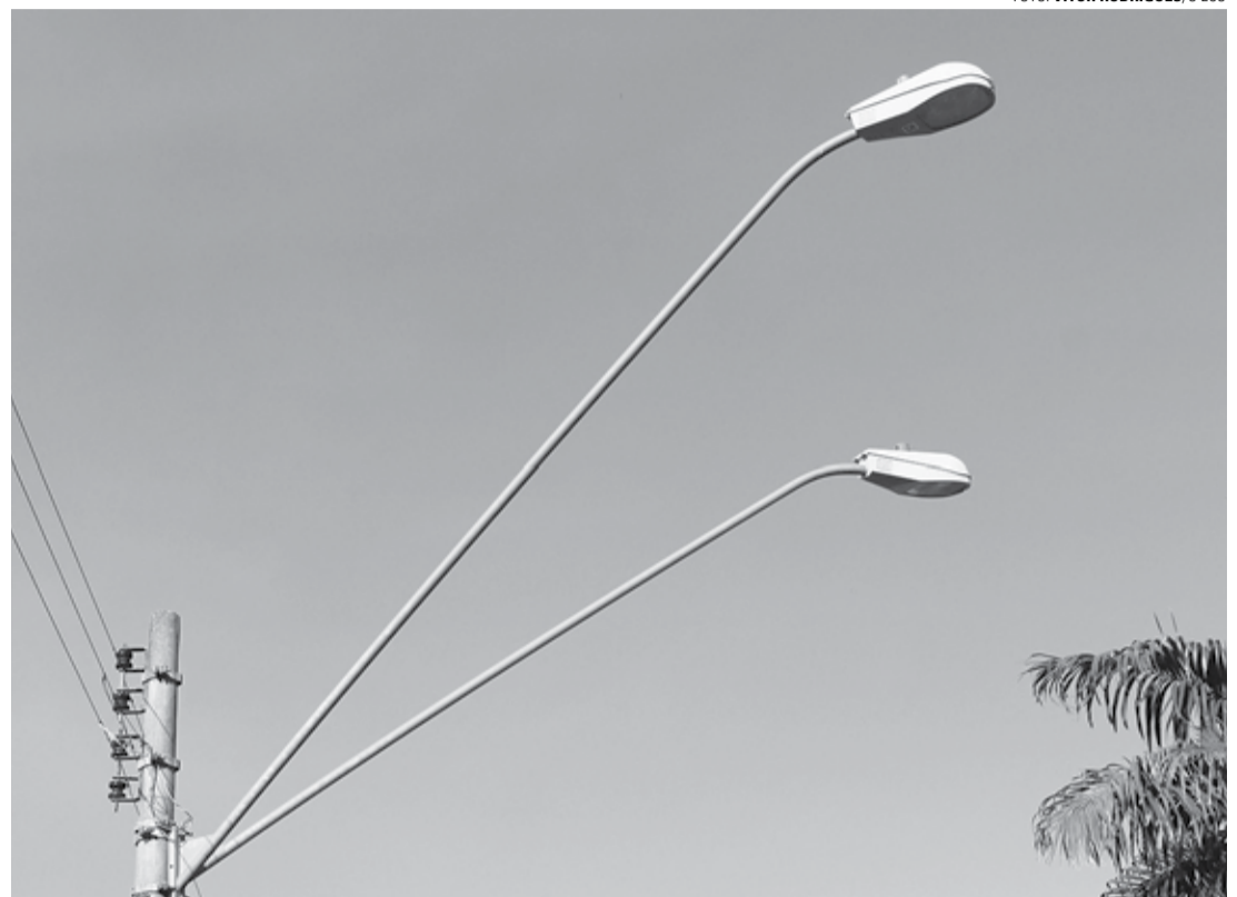
AVANÇO - Com investimento de R$ 6,8 milhões, toda a cidade deve ganhar lâmpadas de LED
