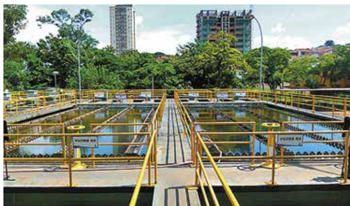
ESTRUTURA - SAAE trata e distribui cerca de 32 milhões de litros de água por dia; 52% passam pela Estação de Tratamento e 48% são oriundos de 15 poços artesianos
