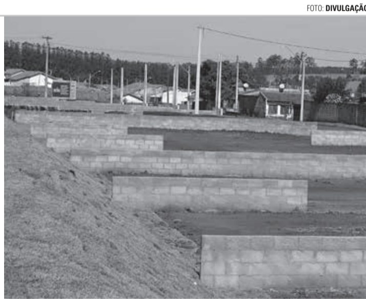
OBRAS - Implantação de conjuntos habitacionais já está em andamento em Areiópolis
