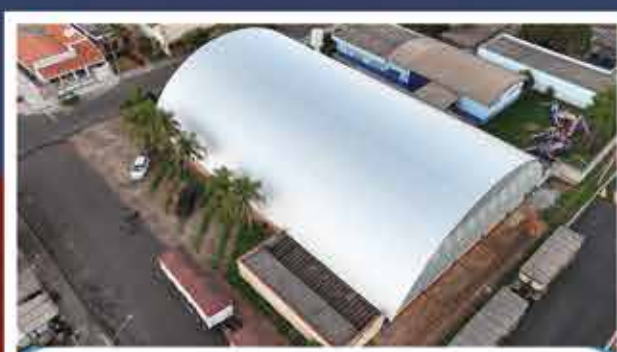
Reforma do ginásio de esportes municipal
