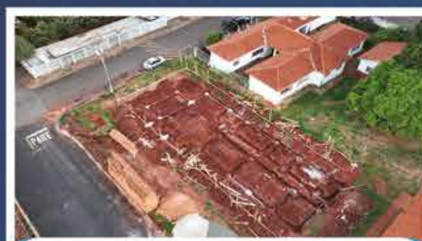
Construção do Novo PSF Vila Cremer
