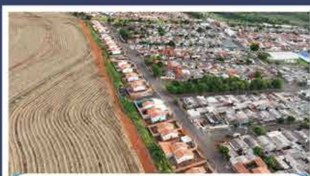
Construção de 34 casas Prefeito João Cadete
