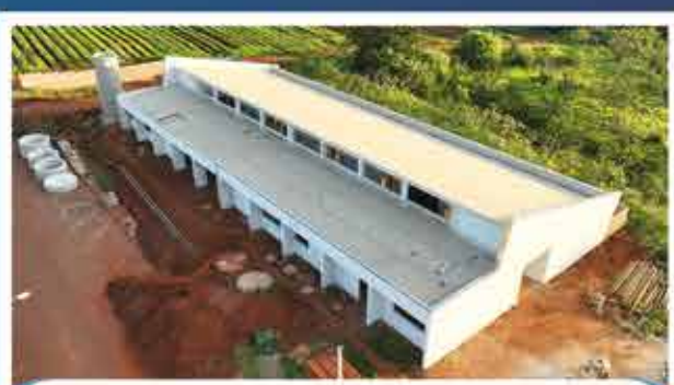
Construção da creche Maria de Lourdes Zuntini (Dóia)
