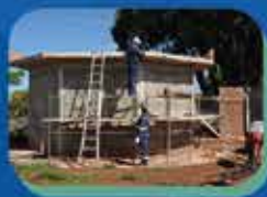
Instalação de Poço Profundo, Reservatório de Água e Fonte Cecap
