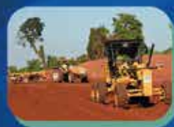
Pavimentação da Rodovia Osni Mateus (SP-261)
