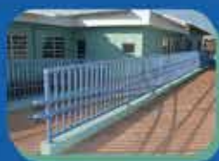
Ampliação da Creche Walt Disney
