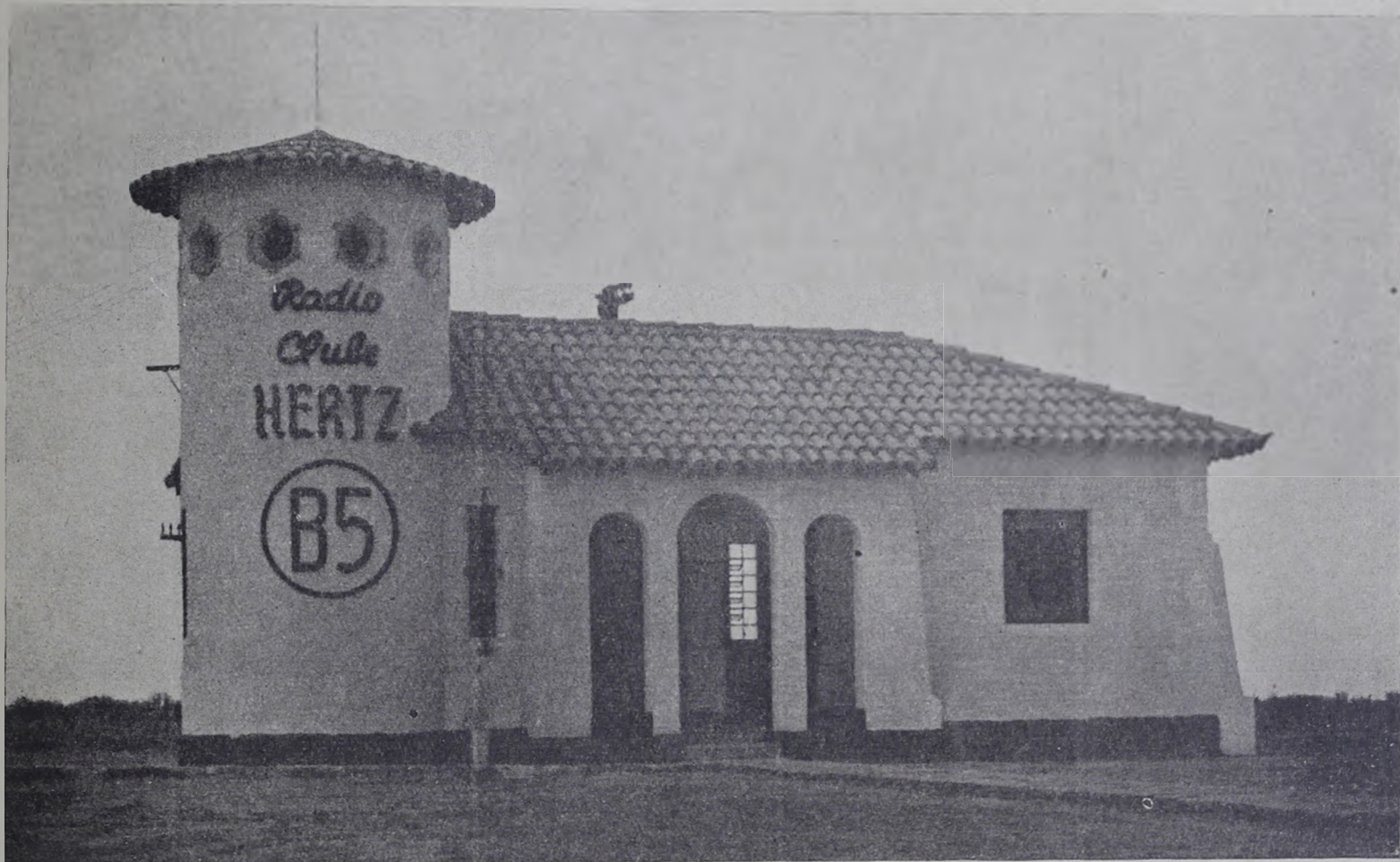
Radio Clube Hertz — PRB 5 — Franca — Estado de São Paulo. Prédio recentemente construído, fora do perímetro urbano, à Avenida Bom Jardim 1111, exclusivamente destinado aos transmissores.
