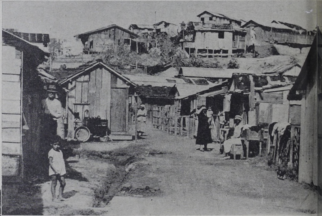
Trecho da favela do Largo da Memória, que foi destruída pelo fogo.
