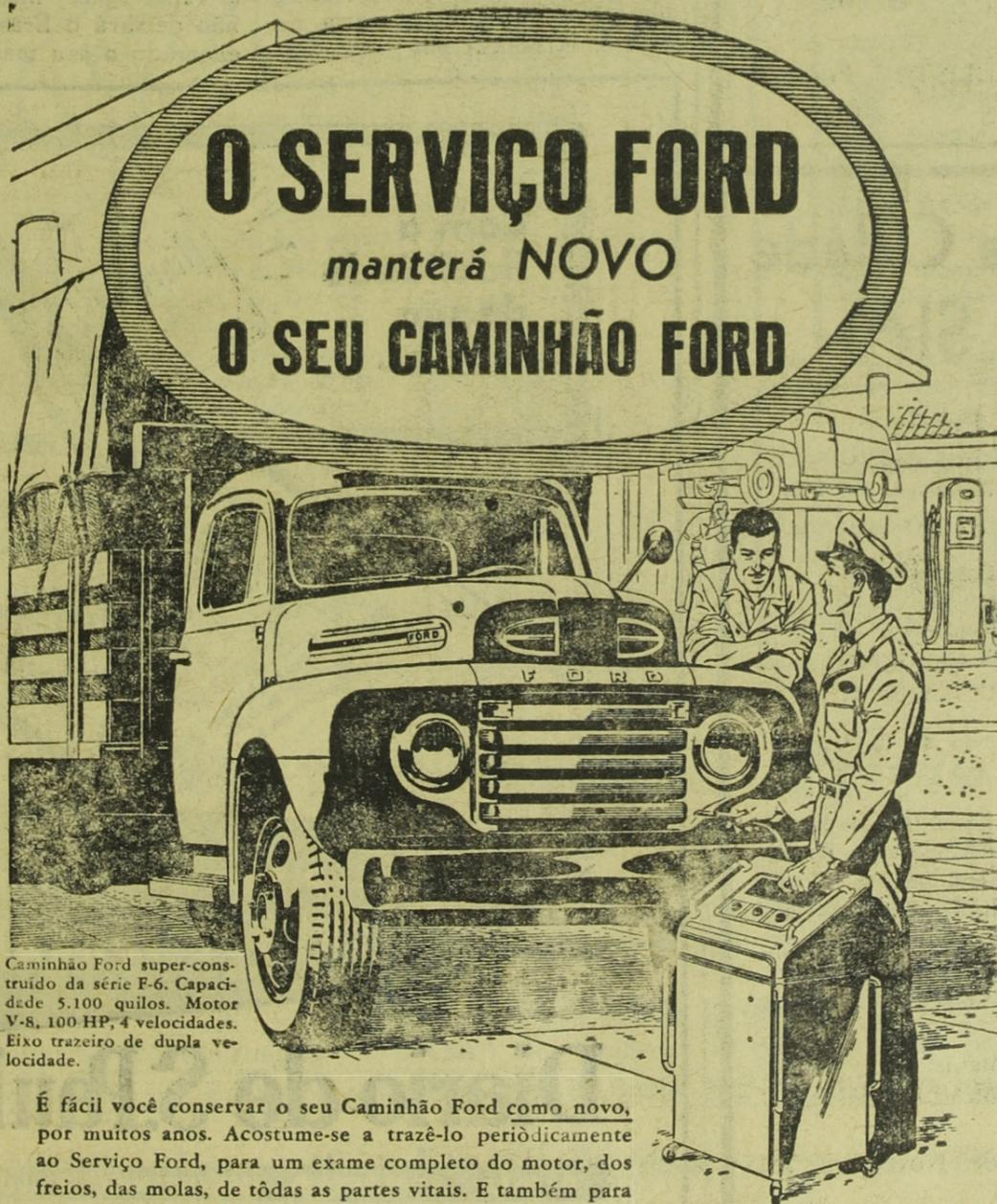
Caminhão Ford super-construído da série F-6. Capacidade 5.100 quilos. Motor V-8, 100 HP, 4 velocidades. Eixo trazeiro de dupla velocidade.
