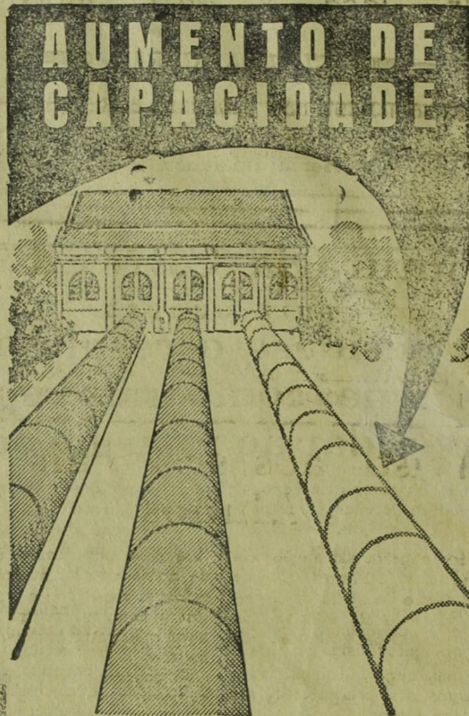
Na usina hidrelétrica de Jaguari está sendo instalada uma terceira unidade geradora de 5.000 quilowatts, como parte de um programa, já em andamento, a ser concluído em breve prazo, que visa aumentar, de 45.000 quilowatts a capacidade geradora do nosso sistema.
