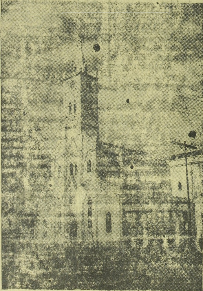
Igreja Matris a espera da sua pintura interna e externa
