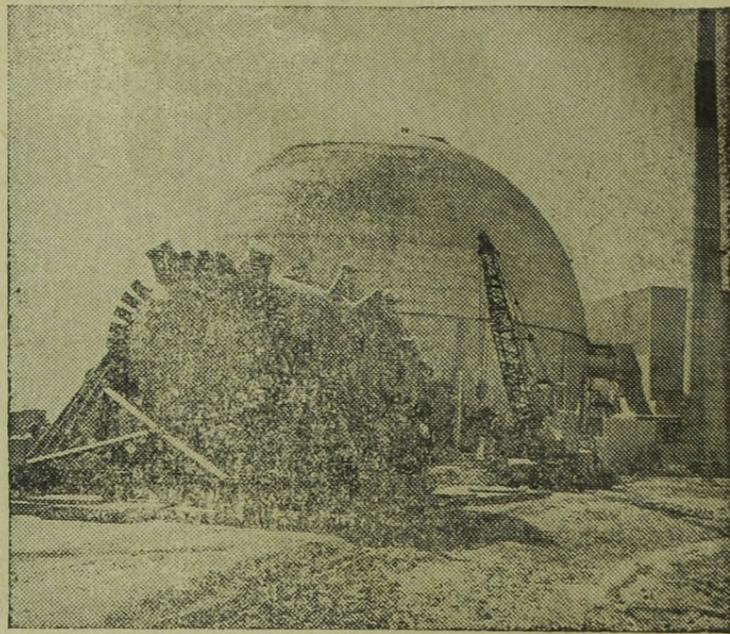
A USINA DE ENERGIA NUCLEAR DE DRESDEN, perto de Chicago, estará inteiramente terminada em fins de 1959, seis meses antes do prazo previsto para sua conclusão. Na foto, vê-se o reator atômico de 300 toneladas pouco antes de ser transportado para o interior da esfera de aço de 57 metros, construída para abrigá-lo.
